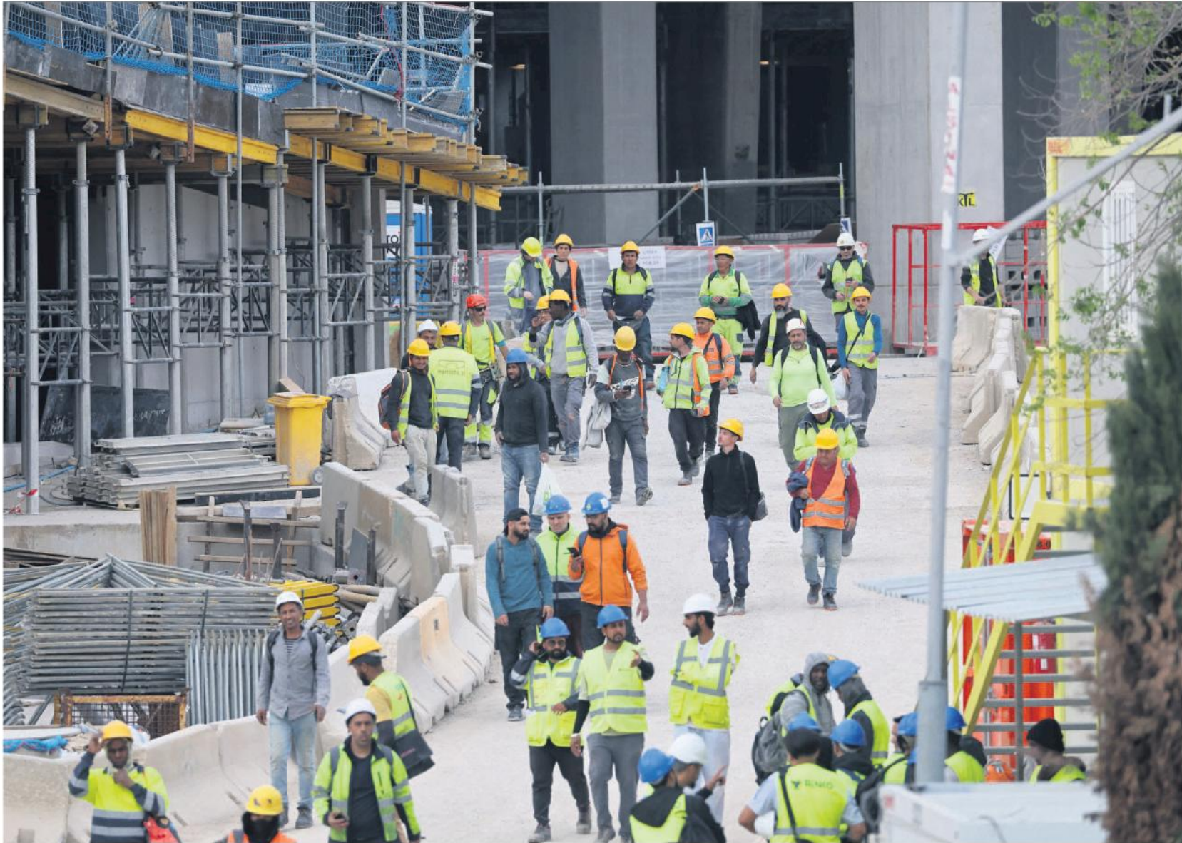
Chantier à Barcelone. Avec la réforme adoptée en février 2022, « 3 millions d'emplois CDI ont été créés », explique Jorge Uxo, professeur d'économie à l'université Complutense de Madrid.
